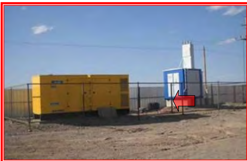
Фотография № 15: Отсутствие разграничения безопасности и предупреждающих знаков
