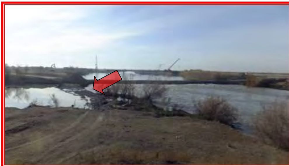
Фотография № 2: Фильтр расположен крайне низко, необходимо увеличить высоту
