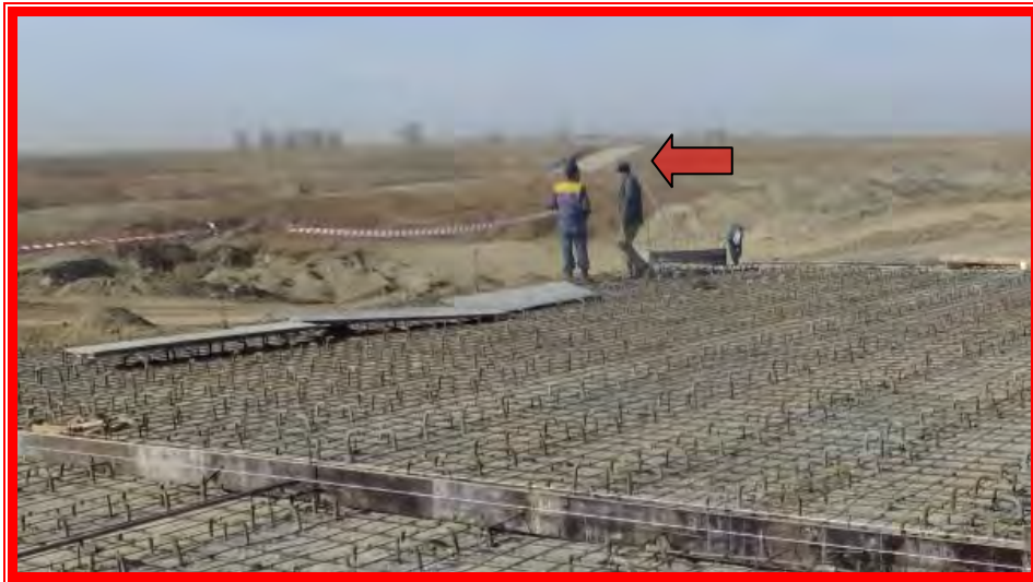
Фотография № 5: Рабочие работают без касок
