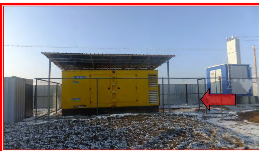
Фотография № 16: Аналогичная ситуация преобладала (отсутствие разграничения безопасности и отсутствие предупреждающих знаков) во время предыдущей проверки
