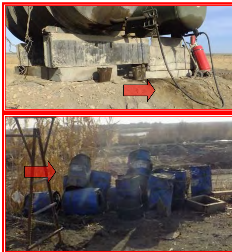
Фотография № 8: Неправильное управление опасными отходами (разливы и бочки) на территории моста №1. Лагерь субподрядной организации
