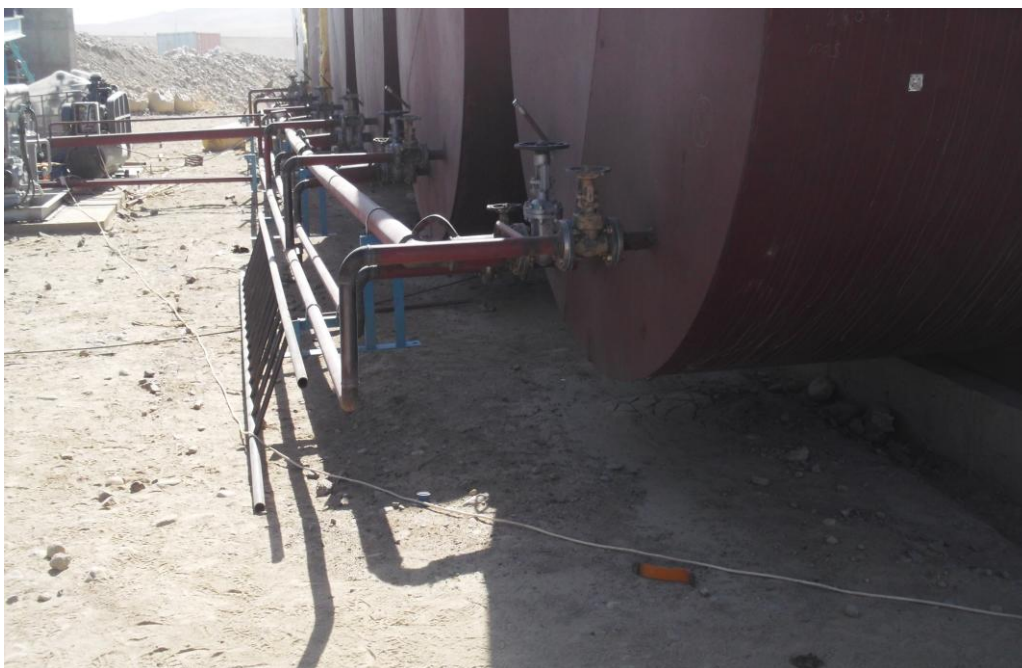
Фотография №7: битумный резервуар без вторичной защитной оболочки
