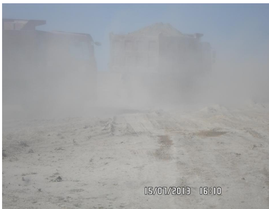
Фотография №1: Чрезмерная запыленность на строй площадках
